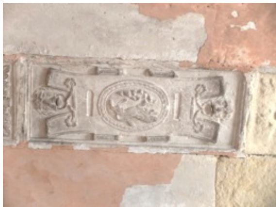
Ci-contre, armoiries de Noël Albert figurant sous la voûte de son bureau
