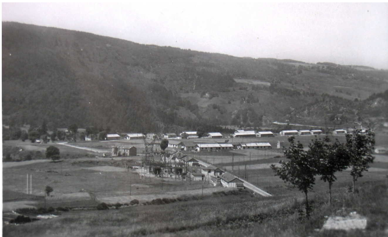
La Palisse - Maisons de chantier
