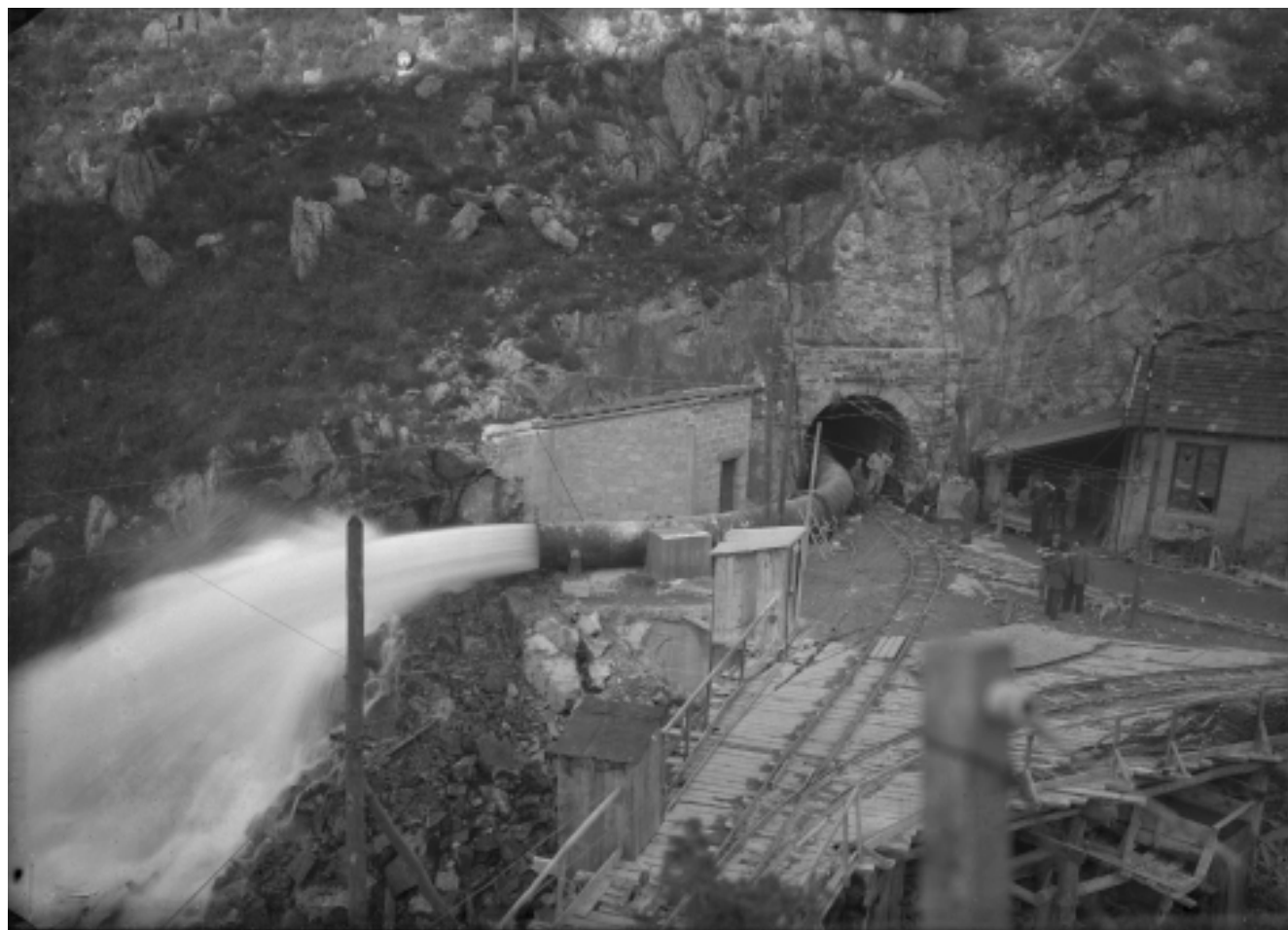
1953 - Lac d'Issarlès - Une conduite forcée
